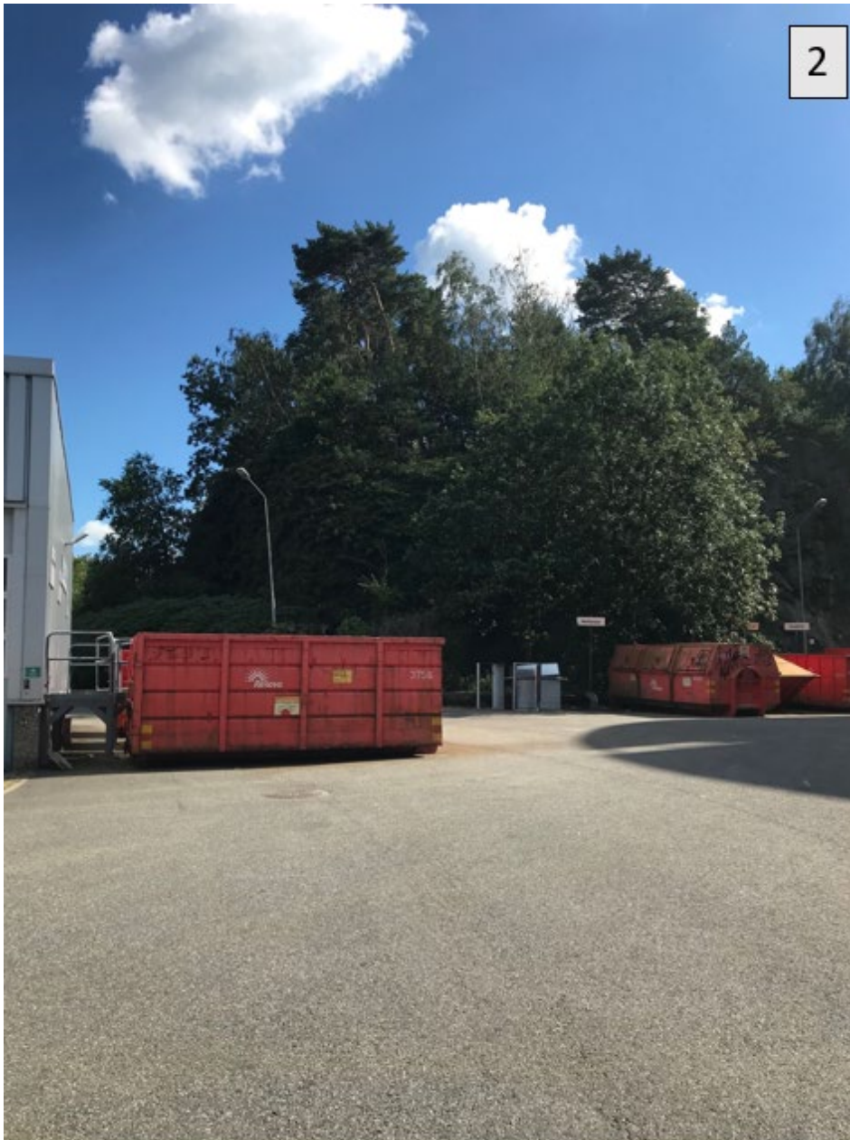
Figur 6. Byggnad ska eventuellt byggas ut som del av utbyggnadsprojektet för befintligt reningsverk. Berg- och naturmarken sprängs då bort för att göra plats. Bild tagen av Adam Santesson, KoV (2022).
