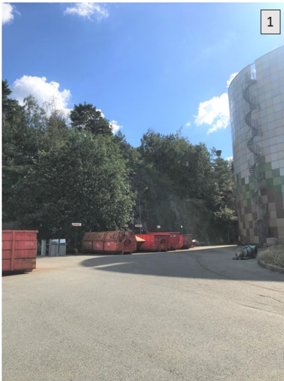
Figur 5. Berg ska sprängas bort och asfalteras för att bygga ut befintligt reningsverk. Bild tagen av Adam Santesson, KoV (2022).
