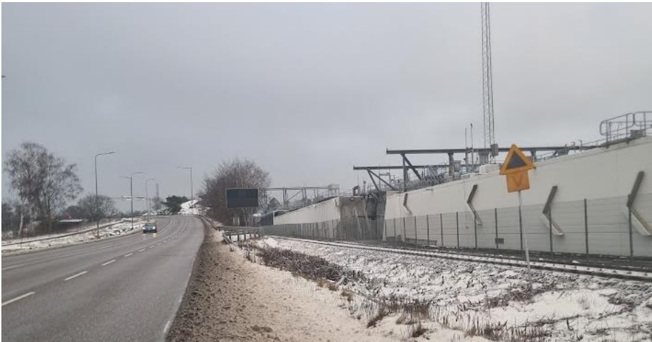
Figur 20. väggkant mot Gryaab fastighet, fotad mot väst
