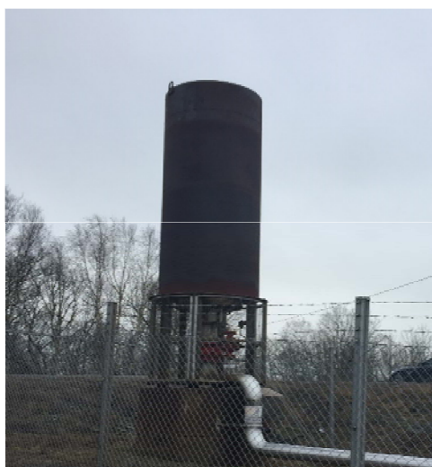
Figur 1 Exempel på utformning av fackla (Syrhåla), facklorna på Ryaverket är från samma leverantör.
