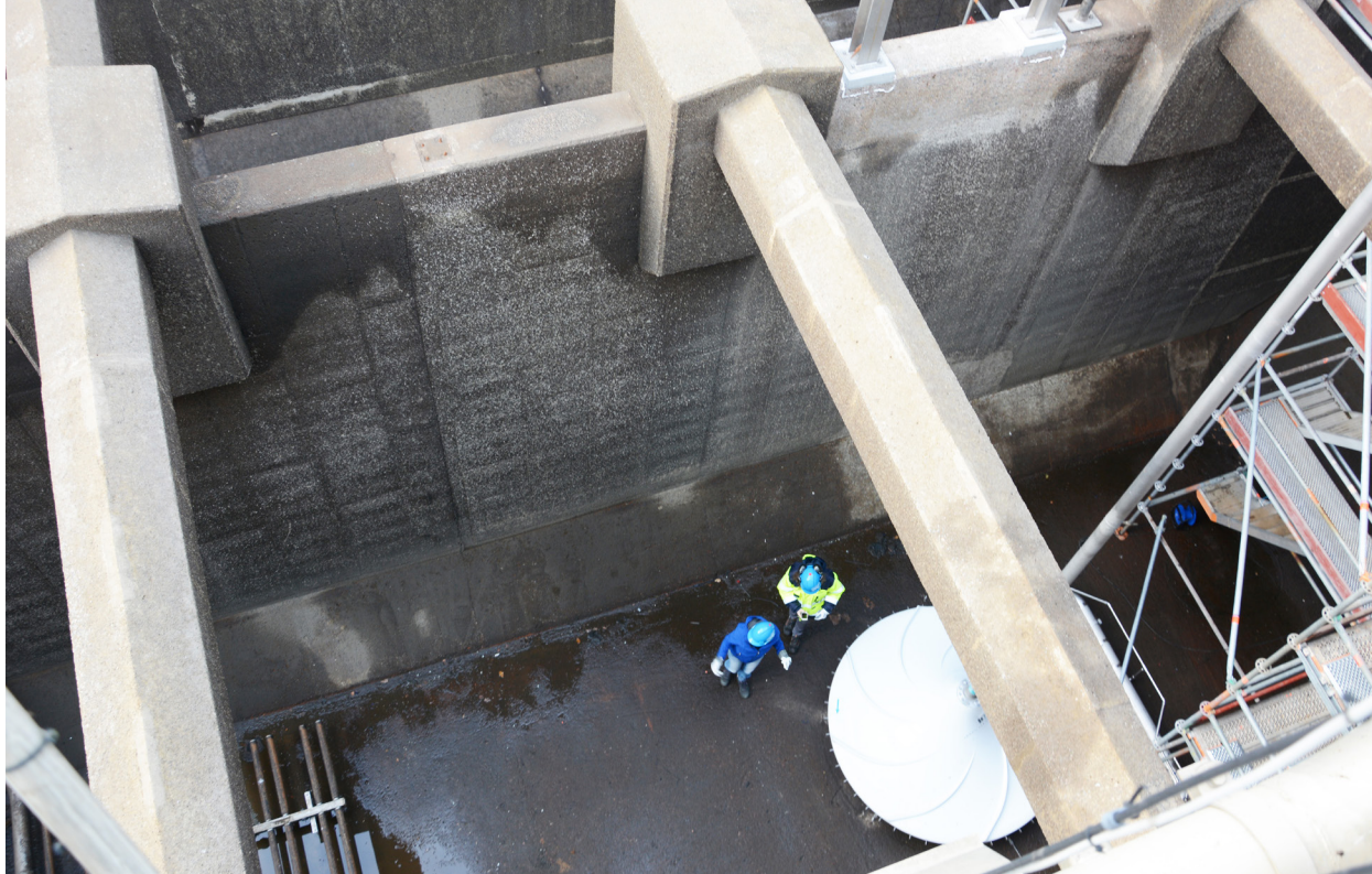
Här monteras nya omrörare och luftare i Gryaabbs aktivslambassänger för att spara energi. Foto: Ellinor Günther, Gryaab
