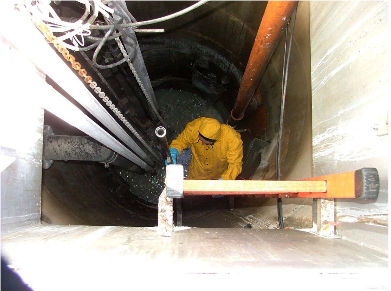
Bilden är från provtagningen i Oxledsvägens pumpstation.
