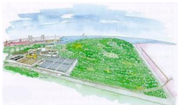
b) Utbyggnad för kväverening med hjälp av rörliga bärare och utbyggnad "på höjden".
